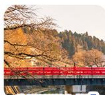
สะพานนากะบาชิ
