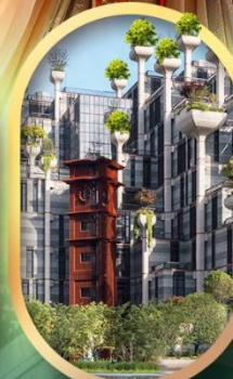
อาคารฟันทันไม้
